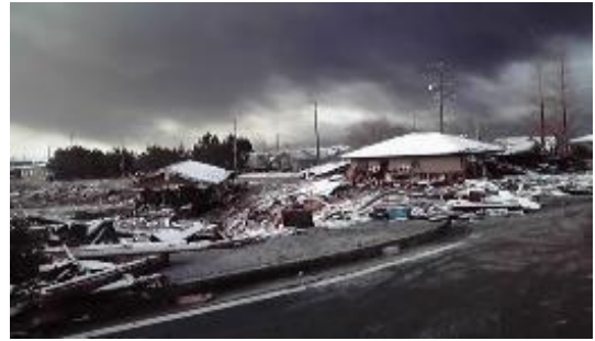
駐車場に斜面を駆け上る津波で流れ着いた住宅2棟
